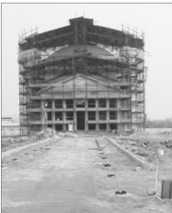
Ristrutturazione in corso. E poi...?
