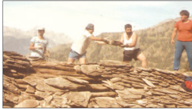
1985 - Campo di lavoro sui tetti a Casalpina
